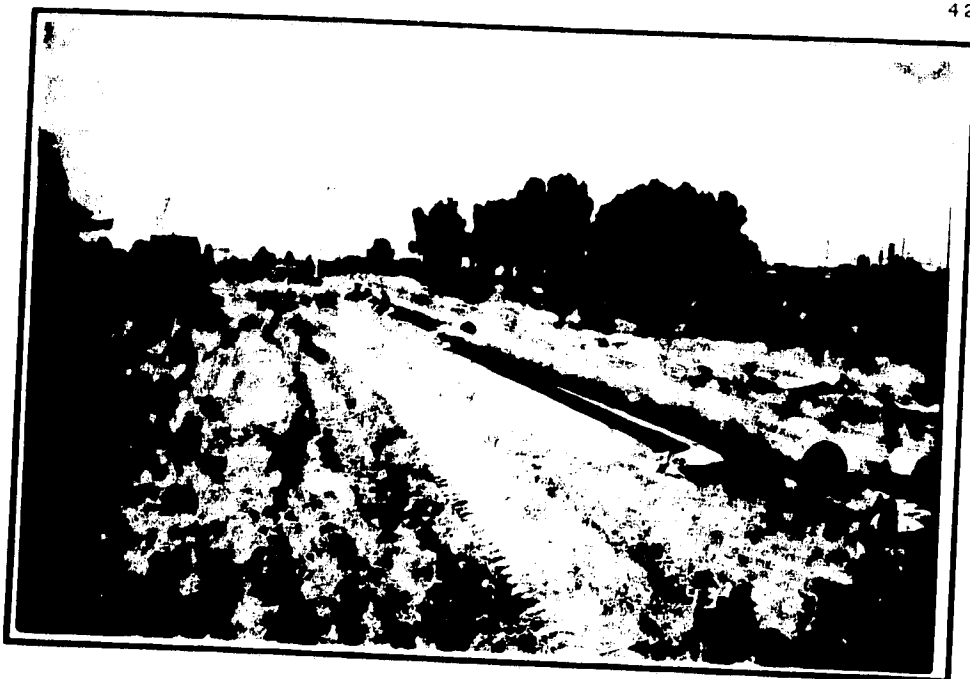
TENDIDO DE TUBO EN EL DERECHO DE VIA
