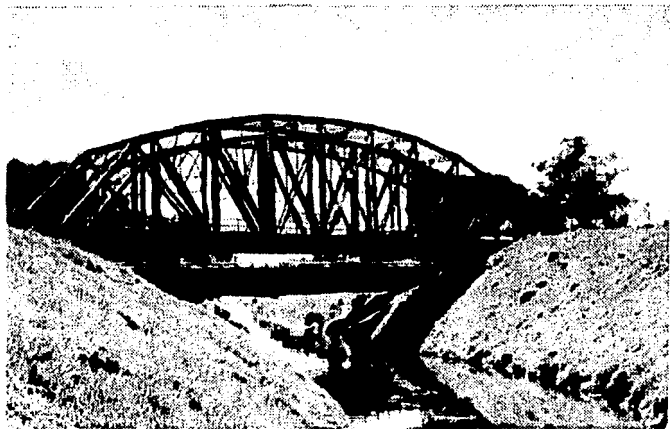
Foto 5 Puente vehicular de calzada inferior
