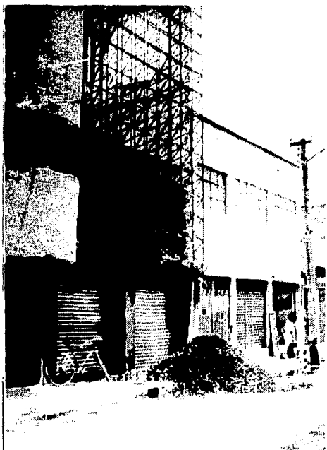
Foto 9 Armadura en centro comercial
