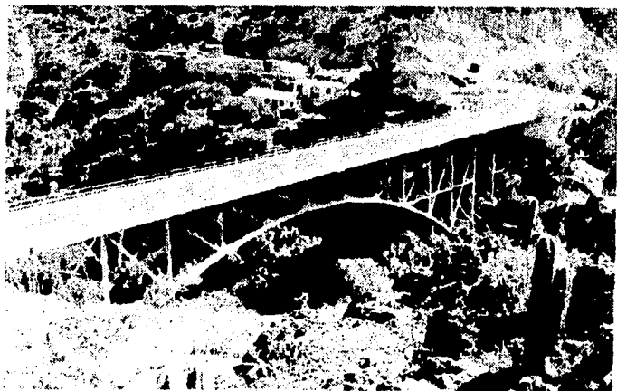
Foto 7 Puente de calzada superior
