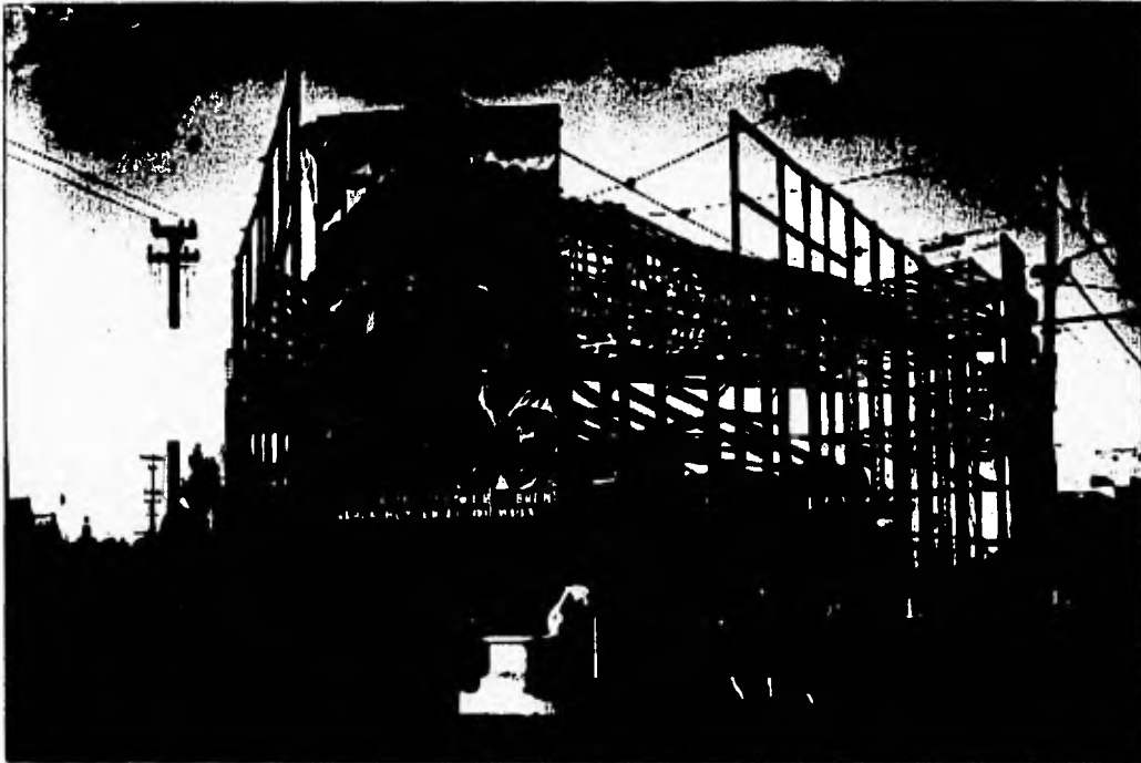
1. Edificio en construcción. AGN. Fondo Enrique Díaz
