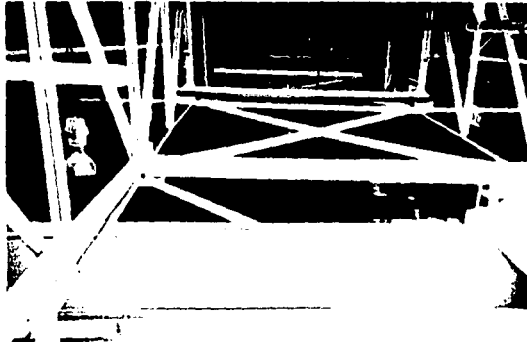
Figura III.6.4. Arreglo del contraventeo de la cuerda inferior a base de ángulo APS de 6" por 3/8.
