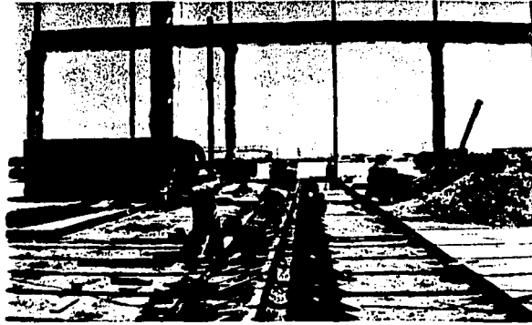
Figura III.6.7. Basta para la rigidización longitudinal de la nave en el proceso del montaje, el arriostamiento que proporciona la trabe carril y los largueros de la techumbre.
