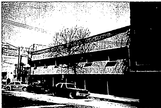
FACHADA DE VECINDAD REMODELADA CON VIVIENDA MÁS AMPLIA
