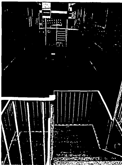
FOTO 37 VISTA DE UN PATIO REDUCIDO POR LAS ESCALERAS
