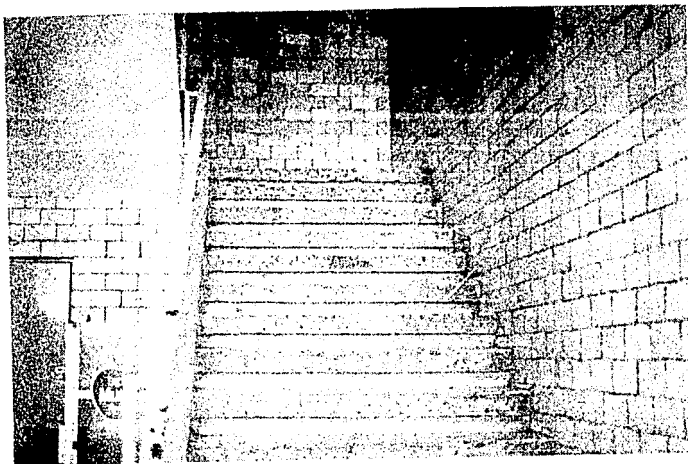
Cubo de escaleras, Central de Bomberos.
