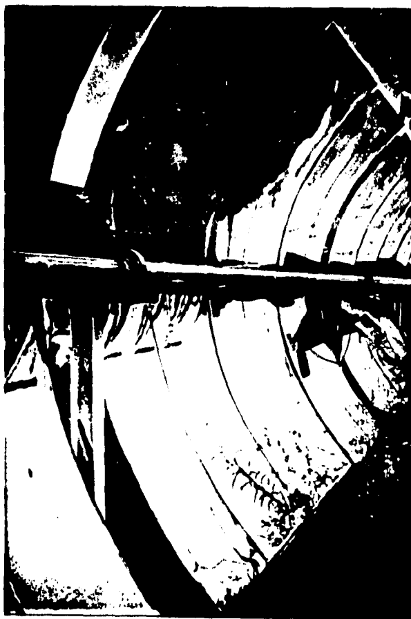
FIG.4.3 Acercamiento del sistema reflector concentrador y tubo absorbedor (PLANTA SOLAR, UNAM).
