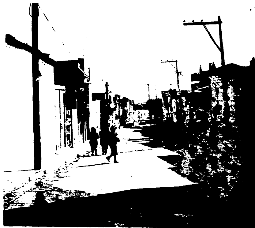
ASPECTO DE LA RED ELECTRICA Y TELEFONICA
