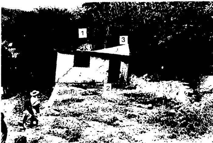
Foto 35. Deformación en una construcción causada por el movimiento diferencial de dos bloques. La casa se encuentra entre la zona estable (1) y uno de los bloques más activos (2). La flecha indica la dirección del movimiento del bloque (2). La esquina trasera (3) se apoya en el bloque estable, por lo que permanece en un nivel más alto.
