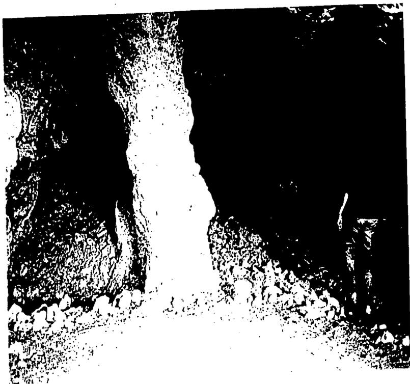
H3.1 Foto de la cueva con el pilar. Este pilar es uno de los muchos que sostienen los techos de cámaras aún en pie. Al remover estos apoyos ocurre el derrumbe de las cámaras, lo que a su vez produce las depresiones.
