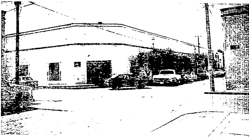
1- VISTA EXTERIOR DEL ACTUAL PALACIO MUNICIPAL.
