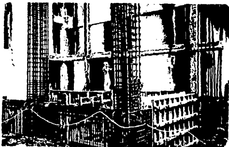
ACERO DE REFUERZO EN CONTRATRABES.
