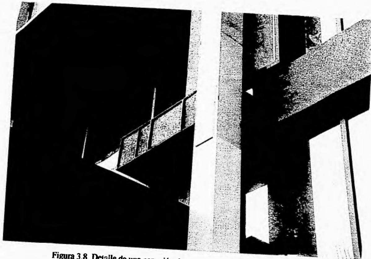
**Figura 3.8. Detalle de una conexión del macromarco y la estructura original**
