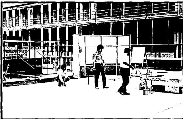
Fotografía 2. Construcción de los módulos del campo.
