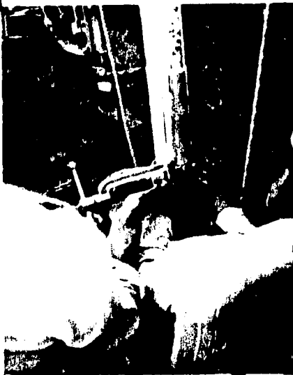
FOTO 10.- SE COLOCAN LOS CINCHOS.
