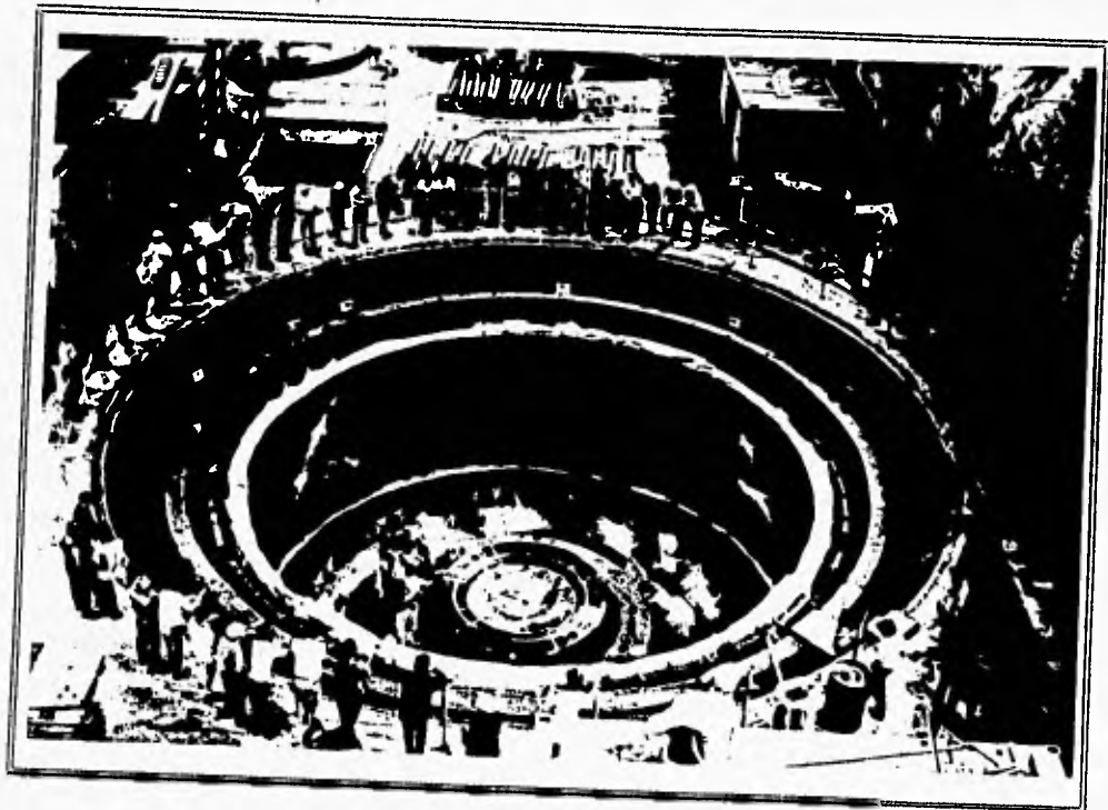
FIG. IV.22 VISTAS DEL FOSO DE TURBINA (ARRIBA: ANTES DE ACOPLAR EL ESCUDO SUPERIOR, ABAJO: LIBERACION DE LA FLECHA PARA ACOPLAR TURBINA CON GENERADOR .
