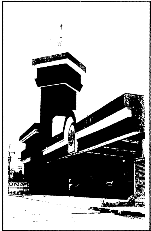
VISTA Calle Simón Bolívar
