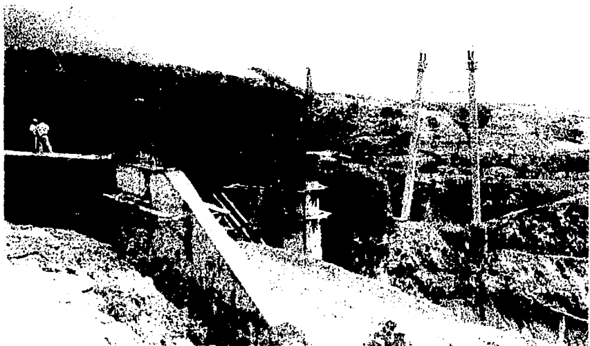
PANORAMICA MOSTRANDO EL AVANCE EN ESTRIBO No 5 Y PILAS 2, 3 Y 4
