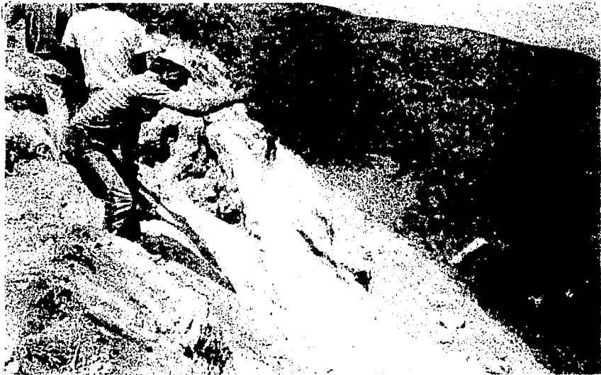
CARGADO DE EXPLOSIVOS EN BARRENACION PARA LA EXCAVACION DONDE SE ALOJARA LA CIMENTACION DE LA PILA N o . 2.
