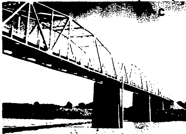
figura 1.6. Superestructuras usadas en puentes: a) tridilora o estructura espacial, b) traves de rececion cajon, c) armadura de caso inferior, d) traves de acero.
