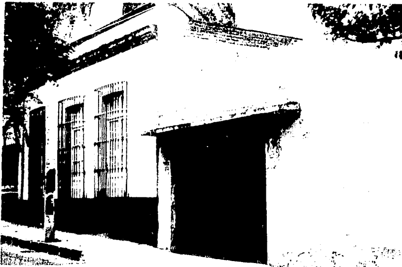
Fotografía F11 Imagen de una casa habitación con un estilo colonial en la calle de
