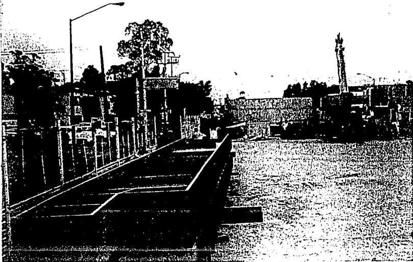
foto no. 11.B Vista de las traves para el montaje de los primeros ejes
