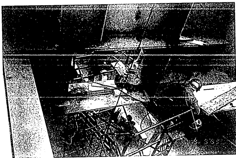
fotos nos. III. 1 y 2 Arreglo de las traves centrales para el insertado de los cables
