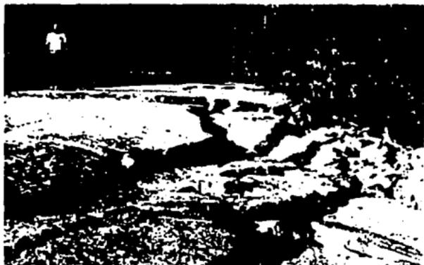
FIGURA 3.5, Colapso y asentamiento del relleno de una carretera durante el terremoto de Chile de 1985
