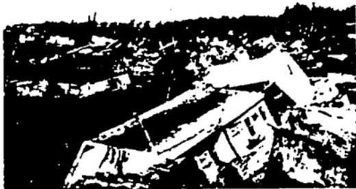
FIGURA 3.6, Deslizamiento, fractura y asentamiento del terreno de licuefacción en Turgain Heights, Anchorage, a consecuencia del terremoto de Alaska en 1964
