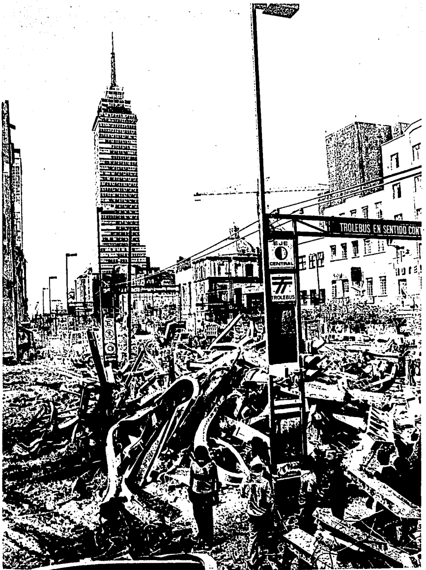
Escombros del edificio "Super Leche", México Df., 1985, Andrés G.
