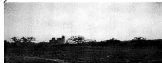
Fabrica de Concretos
