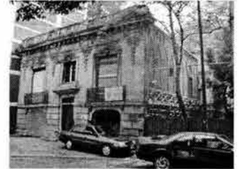
Viviendas con gran deterioro y abandono, Colonia Roma.
