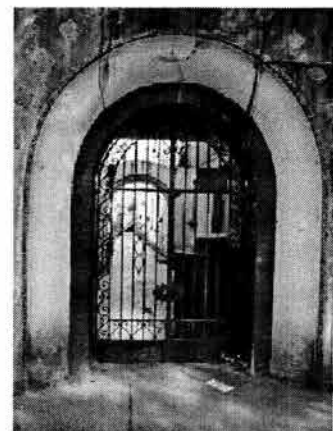
Porta de acceso a patio central
