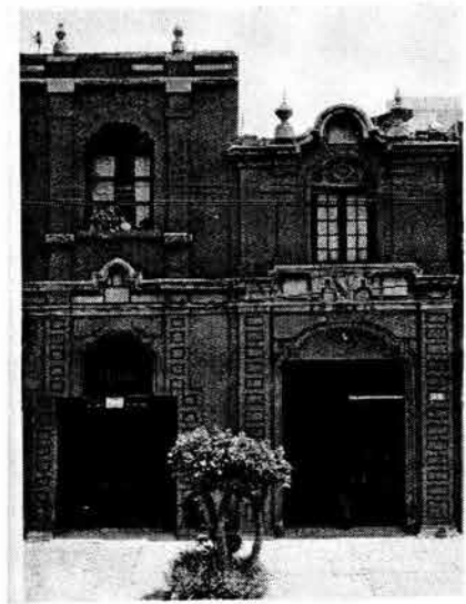
Casa Alvaro Obregón 287, ejemplo arquitectura neo colonial.
