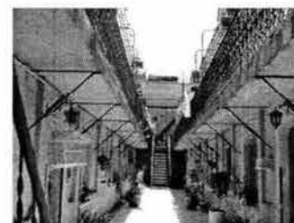
Patio interior, con viviendas localizadas en los extremos longitudinalmente.
