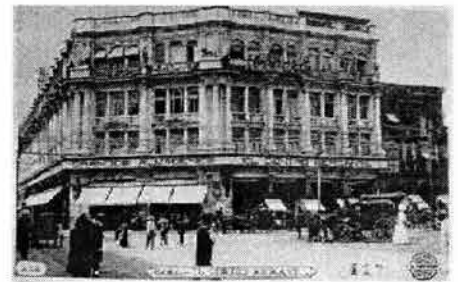
Fachada Centro Mercantil 1908
