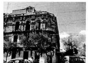
Edificio deteriorado notablemente, colonia Roma.
