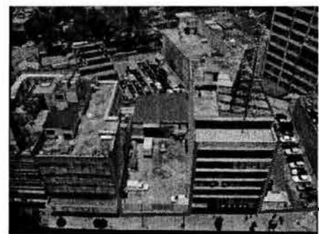
Huecos urbanos que no conforman volumétricamente las manzanas.
