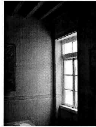
Cancelería de madera, muros con aplanado de yeso, estancia
