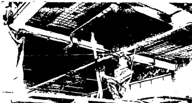
Reforzamiento de una losa de piso de concreto reforza- do, con concreto lanzado colocado de abajo hacia arriba.
