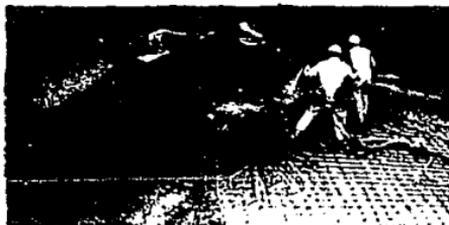
Techo de un paraboloides hiperbólico en construcción, en Vancouver, Canadá.
