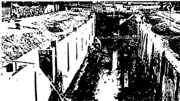
Una esclusa de río construida de mampostería, reforzada con revestimiento de concreto lanzado.
