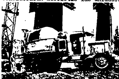
Figura 2.15 Uno de los primeros (1937) camiones revolventores de alta-descarga; es una unidad de 4 yardas cúbicas (3.06 m 3 ).
