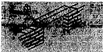
LOS DINTELES SON TRANSPORTADOS Y COLOCADOS MANUALMENTE, ESTOS SE UTILIZAN EN CERRAMIENTOS DE VENTANAS Y PUERTAS
