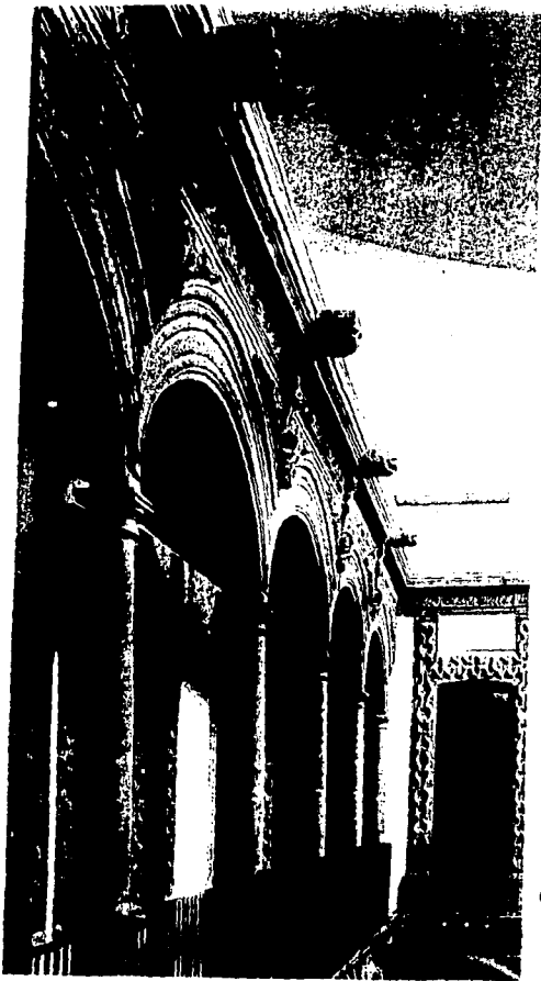
Patio, arcos del segundo piso.
