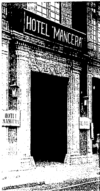
Casa-Palacio del Marqués de Selva Nevada.
