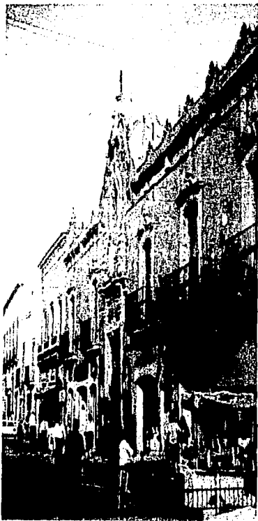
Palacio Casa del Marqués de la Villa del Villar de la Aguila.
