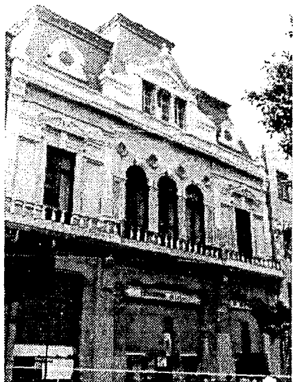
Residencia Urbana en la calle de Tacuba, conocida como la "Casa de Mármol".
