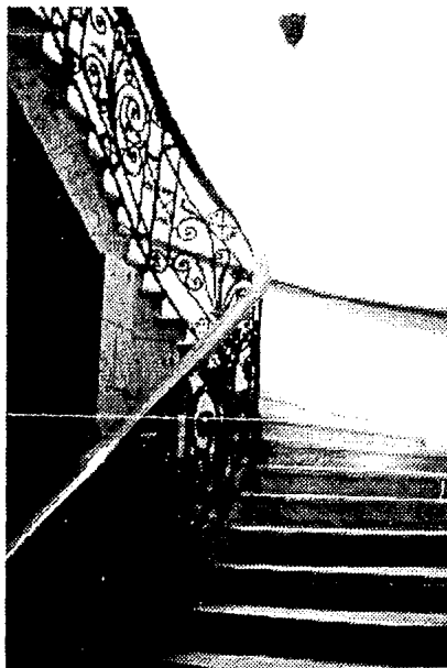
Escalera en la casa de Uruguay # 49 restaurada.
