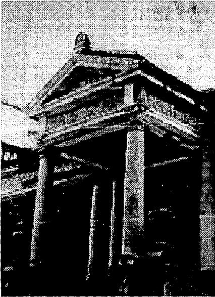
Casa en Heroes #45. Pórtico de acceso.
