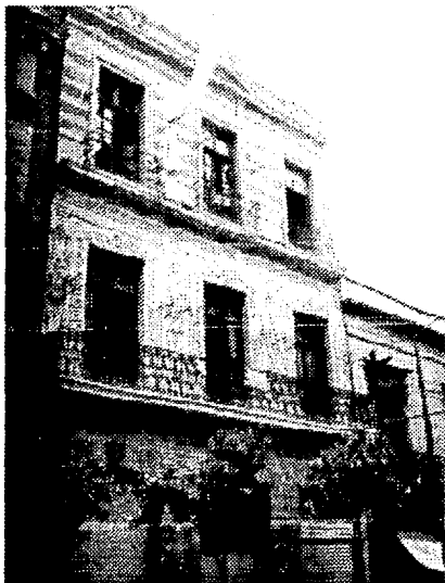
Casa en la calle de Uruguay en proceso de restauración.
