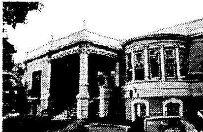
Casa Lamm. Fachada hacia el jardín.
