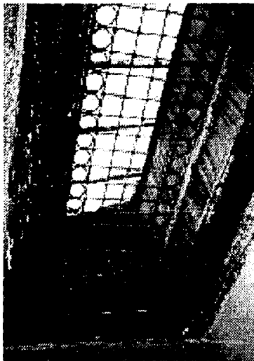
Casa en Heroes #45. Tragaluz sobre el pasillo en la planta alta.
