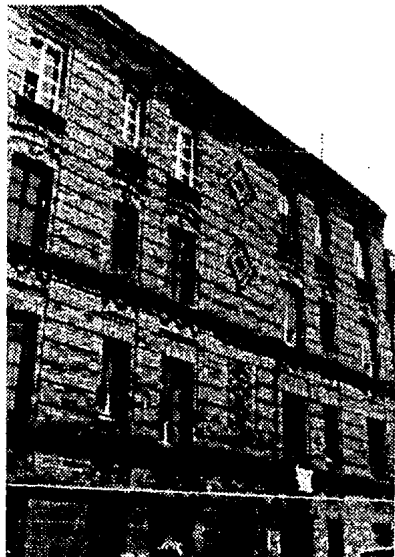
edificio de renta en Santa María la Rivera. (tabique)
