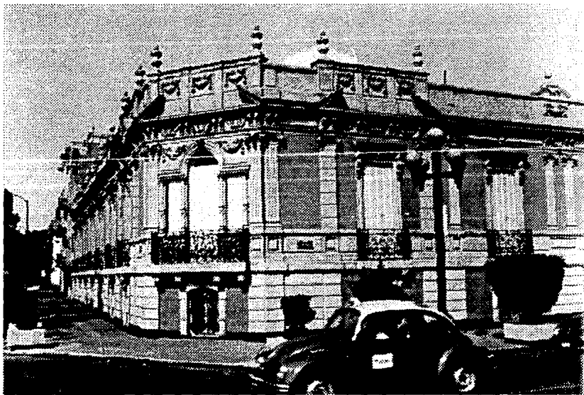
Casa Lamm. 1911. Un ejemplo de restauración y reutilización.
