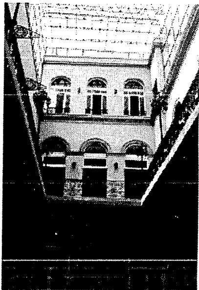
Patio de la casa en Uruguay #49 restaurado.
