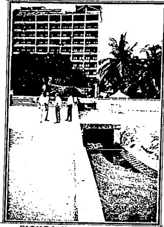
FIGURA No 4.5 DESEMBOCADA DE LA VENA STA. ELENA EN LA PLAYA DEL HOTEL BUMBILIAS SHERATON, MARGEN DERECHA, AGUAS ARRIBA.
