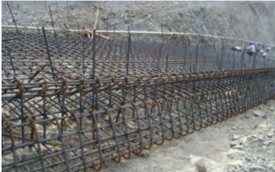
Fotografía 5.4-1. Vista del armado en el cabezal del plinto tramo 11-12.
