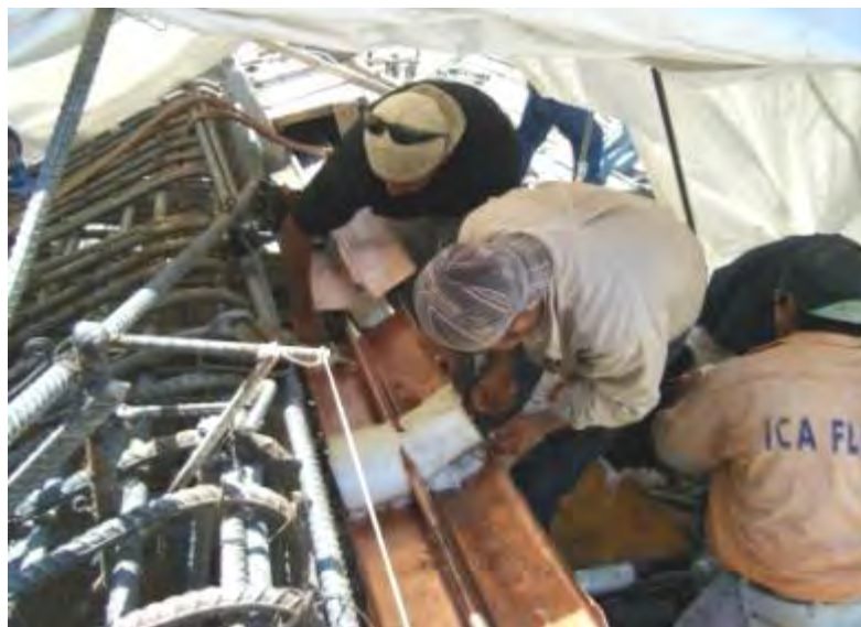
Fotografía 7.1-3. Limpieza de los elementos previo a la soldadura.
