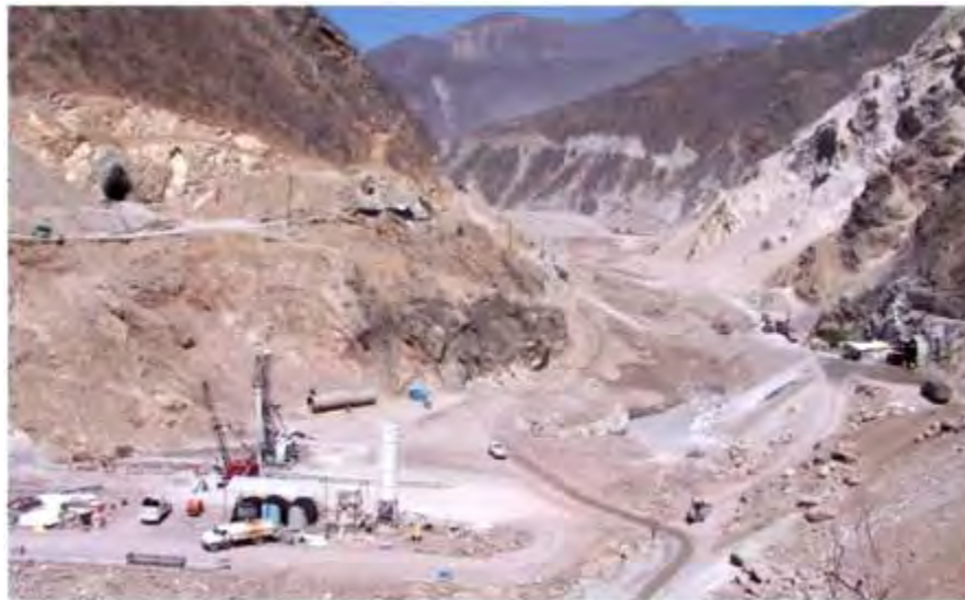
Fotografía 4.5-1. Margen izquierda y margen derecha previo a las excavaciones para desplante del plinto
