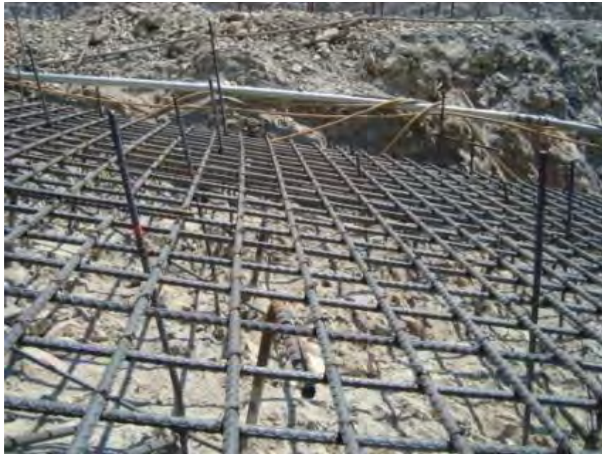
Fotografía 4.5.3-1. Detalle de armado para plinto tramo 11-12 con espesor de 70 cm.
