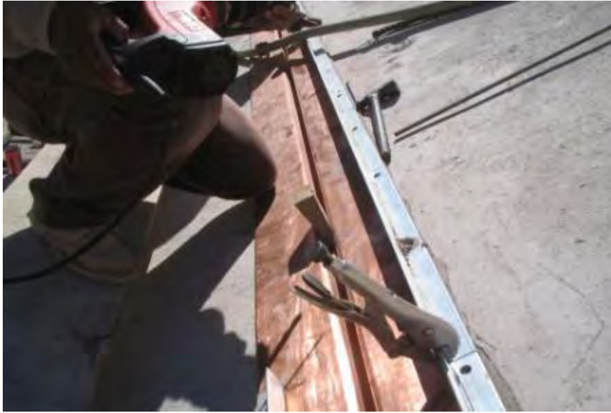
Fotografía 6.7-3. Sujeción del sello de cobre en la C.H. El Cajón, (Nayarit, México). Cortesía ICA.
