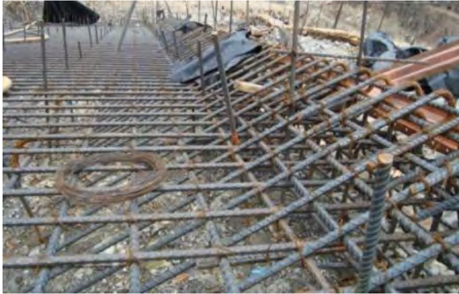
Fotografía 5.4.1-3. Detalle del armado del cabezal.
