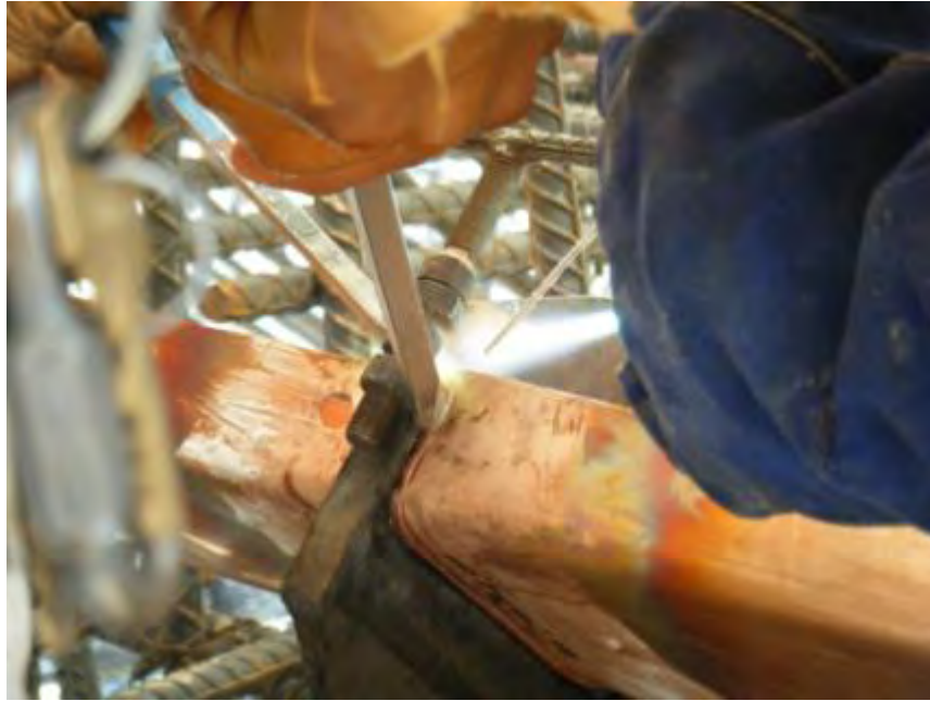
Fotografía 7.1-10. Proceso de soldadura en un extremo del sello.
