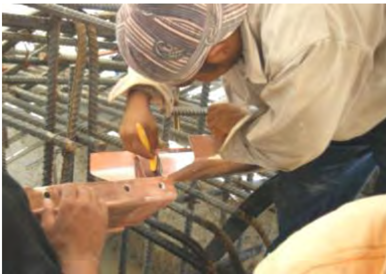
Fotografía 7.1-4. Colocación de la capa de material fundente en los elementos de cobre.
