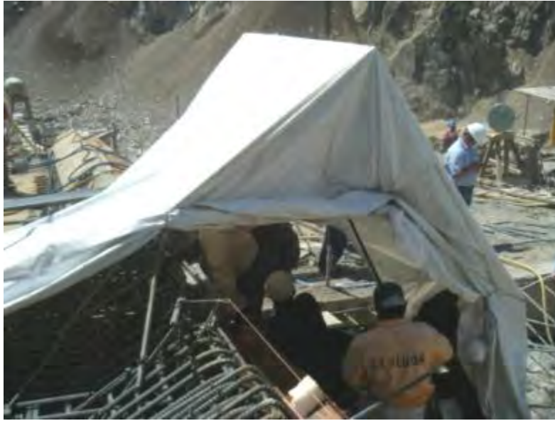
Fotografía 7.1-2. Protección de la zona de trabajo en obra.
