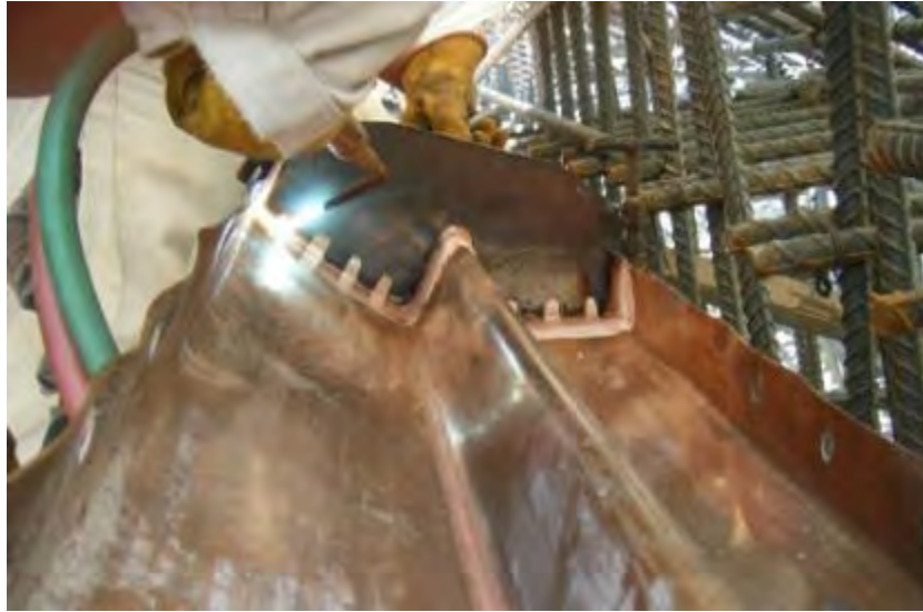
Fotografía 7.1-8. Soplete calentando el cobre.
