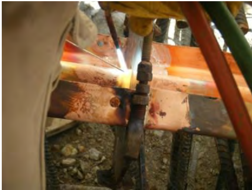
Fotografía 7.1-11. Proceso de soldadura en el bulbo del sello.
