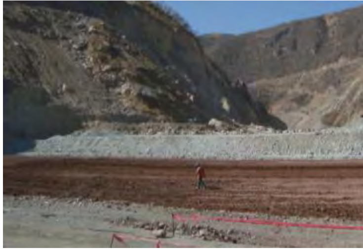
Fotografía 2.2.1-2. Núcleo de material cohesivo.
