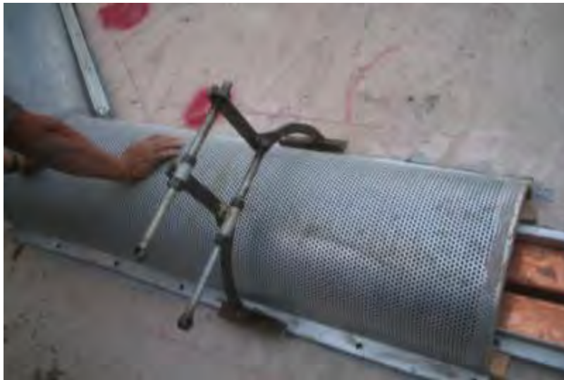
Fotografía 6.9.1-3. Colocación del contenedor de ceniza sobre el sello superior de cobre. Cortesía ICA.
