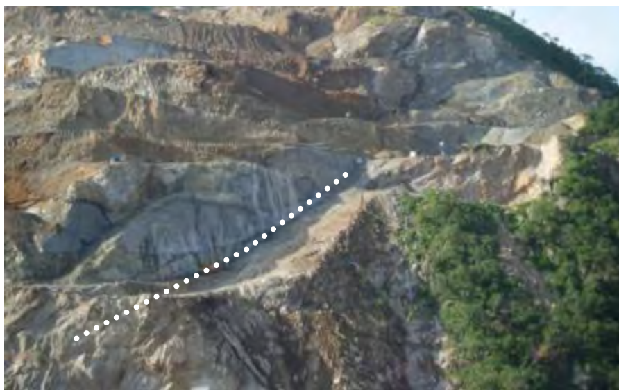
Fotografía 4.5-2. Excavación margen izquierda para desplante del plinto.
