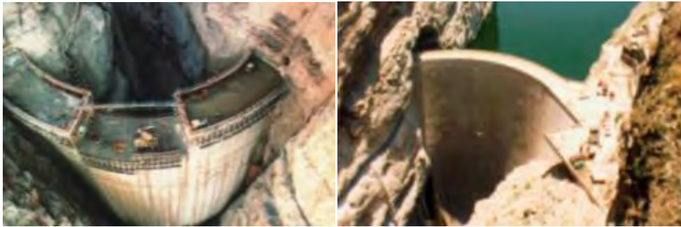
Fotografía 1.2-4. Central hidroeléctrica Zimapán (Hidalgo, México) cortina tipo arco-bóveda. Cortesía C.F.E.
