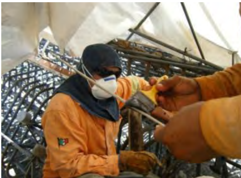
Fotografía 7.1-6. Colocación de fundente sobre la soldadura desnuda.
