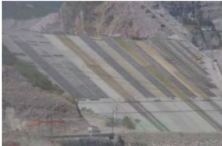
Fotografía 3.1-2. Construcción parcial de la cara de concreto C.H. El Cajón. (Nayarit, México). Cortesía C.F.E.
