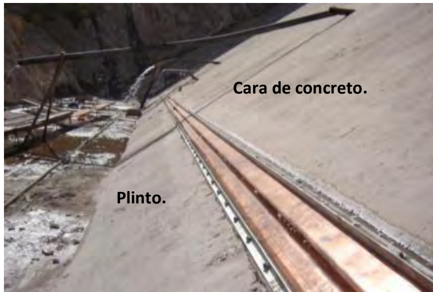
Fotografía 6.7-4. Sello superior colocado en la C.H. El Cajón, (Nayarit, México). Cortesía ICA.
