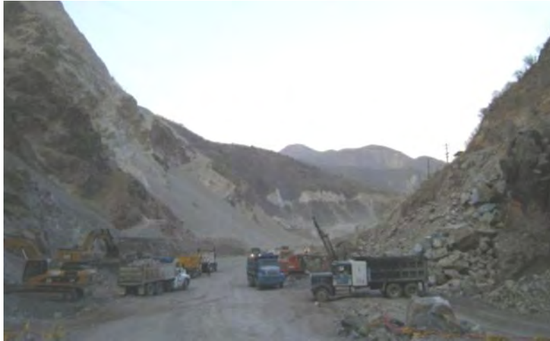
Fotografía 1.3-2. Boquilla Proyecto hidroeléctrico La Yesca (después del desvío del río).
