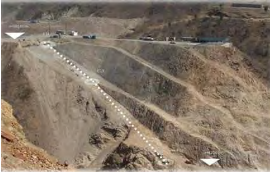
Fotografía 4.5.1-1. Trazo del eje del plinto margen derecha.
