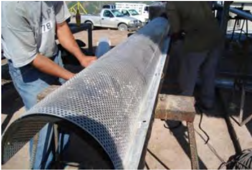
Fotografía 6.9.1-2. Colocación del geotextil entre los contenedores. Cortesía ICA.
