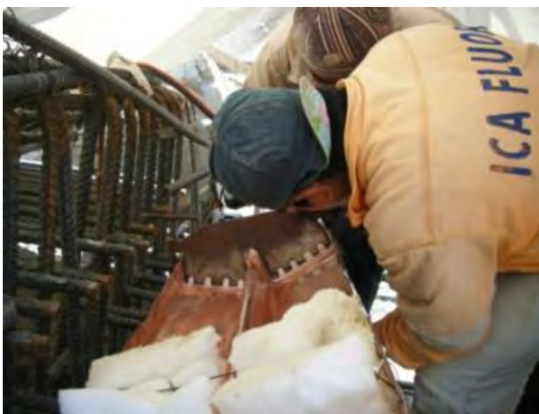
Fotografía 7.1-5. Colocación de la prensa que presiona los traslapes.
