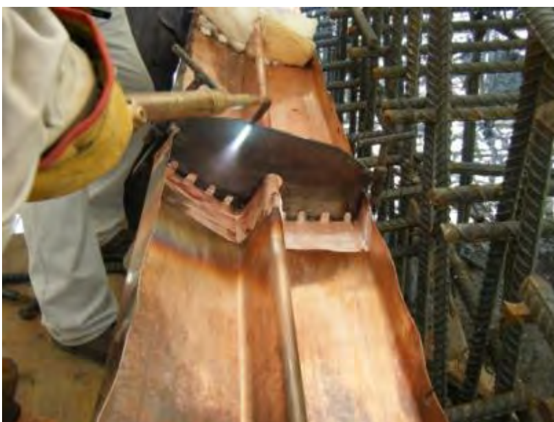
Fotografía 7.1-7. Inicio proceso de soldadura.
