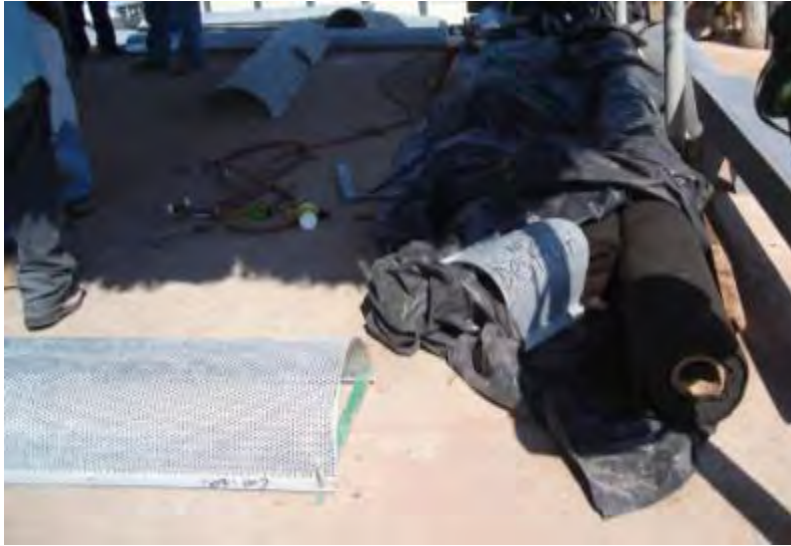
Fotografía 6.9-2. Contenedor galvanizado y geotextil. Cortesía ICA.
