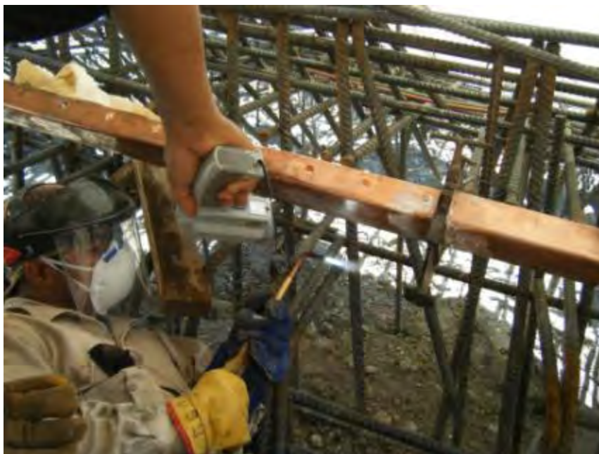
Fotografía 7.1-13. Revisión de la temperatura con el termómetro infrarrojo.
