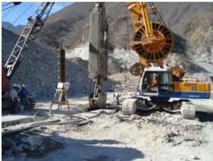
Fotografía 2.2.4-4. Construcción de una pantalla impermeable.
