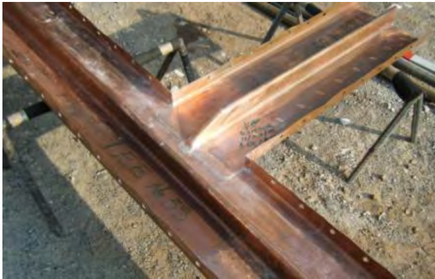
Fotografía 6.5-1. Tee habilitada en el taller
