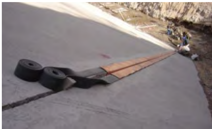
Fotografía 6.7-2. Colocación del sello superior de cobre sobre las bandas de neopreno en la C.H. El Cajón (Nayarit, México). Cortesía ICA.
