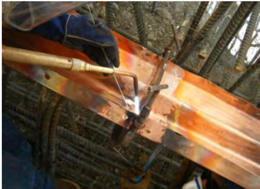
Fotografía 7.1-9. Proceso de soldadura al interior del sello.
