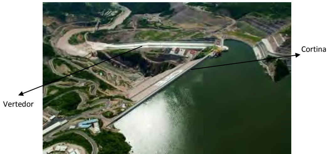
Fotografía 1.3-3. Central hidroeléctrica El Cajón, se aprecia la cortina y el vertedor con las compuertas en operación. Cortesía C.F.E.
