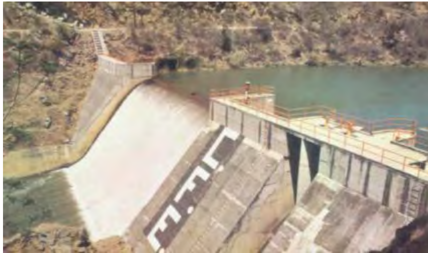
Fotografía 1.2-2. Presa Tilostóc (Estado de México, México) cortina tipo gravedad. Cortesía C.F.E.
