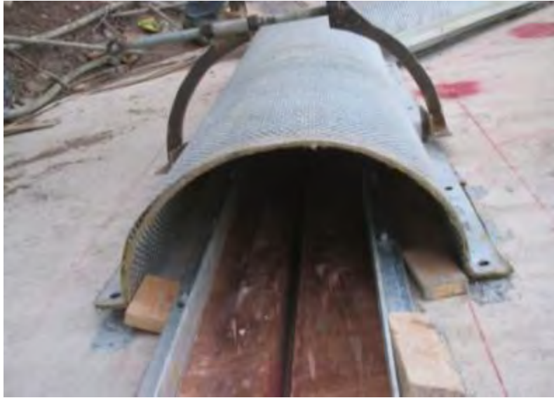
Fotografía 6.9.1-4. Colocación del contenedor de ceniza sobre sello superior de cobre. Cortesía ICA.
