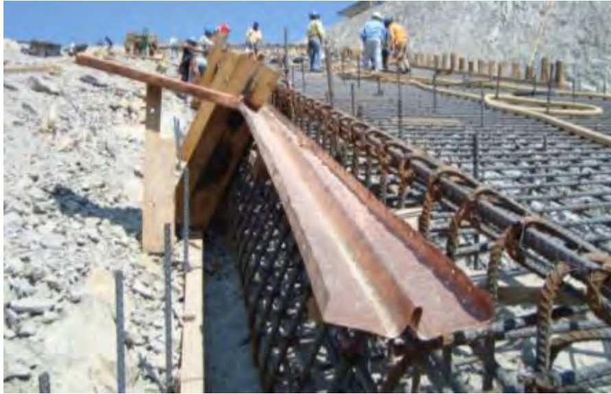
Fotografía 6.5-2. Tee colocada en el plinto.
