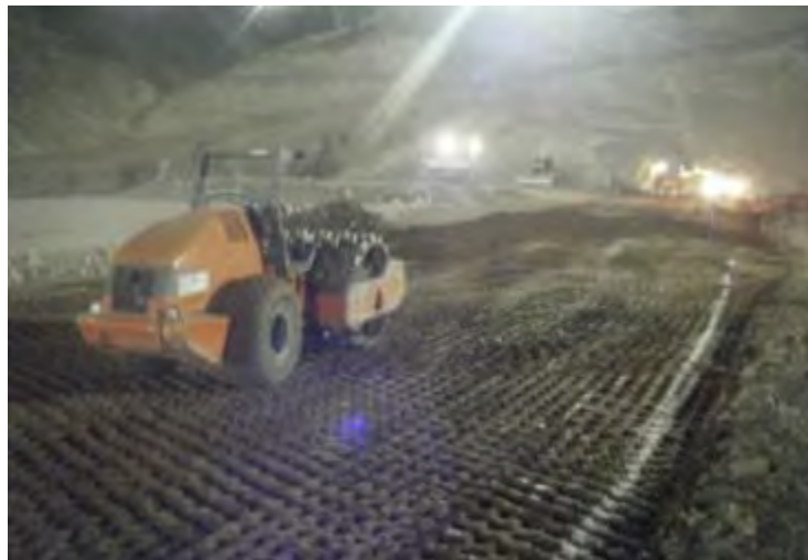
Fotografía 2.2.1-1. Compactación del material cohesivo para el núcleo.
