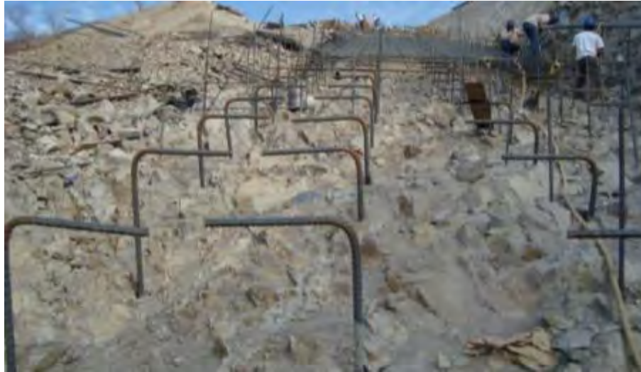
Fotografía 5.5-2. Colocación del anclaje para el plinto.
