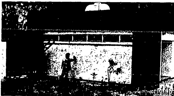
42. LIMPIEZA DEL MURO. ARRIBA, CON CEPILLOS DE ALAMBRE PARA ELIMINAR LA PINTURA VIEJA (PARTES DEBILES). ABAJO, LAVADO DEL MURO CON CEPILLOS DE CERDA, AGUA Y DETERGENTE NEUTRO.
