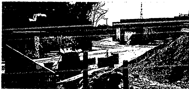
5. ZONA DE ACCESO PRINCIPAL DE LA PLANTA. OBRA EN PROCESO DE CONSTRUCCION.
