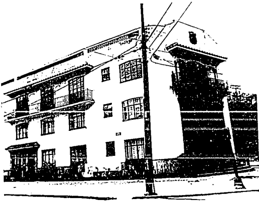
F.48 Edificio Raúl Jorge. Arquímides y Newton. Polanco. 1939-1945
