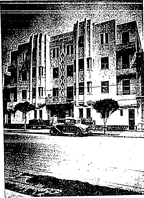
F.20 Edificio Anáhuac. Querétaro # 109. Col. Roma 1932
