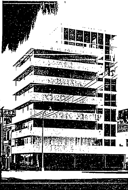
F.17 Condominio Fransarq. 1961-1962 Semidestruido.
