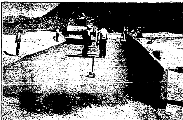
FIGURA 5.4.3.- EL VIBROCOMPACTADOR REALIZA DE 3 A 6 PASADAS PARA OBTENER EL GRADO DE COMPACTACION OPTIMO REQUERIDO. BORDO DE PRUEBAS. PRESA SAN LAZARO, B.C.S.
