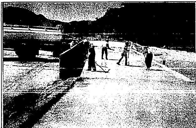
FIGURA 5.3.2. LIMPIEZA DE LA BASE DE CONCRETO CONVENCIONAL UTILIZANDO -- CHIFLON DE AIRE-AGUA A PRESION, MOMENTOS ANTES DE INICIAR LA COLOCACION DEL CONCRETO COMPACTABLE. BORDO DE PRUEBAS, PRESA SAN LAZARO, B.C.S.
