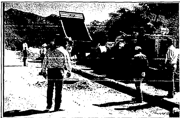
FIGURA 5.3.7.- EL CONCRETO COMPACTABLE ES DISPERSADO INICIALMENTE POR UN CARGADOR FRONTAL, EVITANDO ASI, UNA SOBRECMPACTACION EN LA CAPA OCASIONADA POR EL PASO DE LOS NEUMATICOS DE LA MOTOCONFORMADORA AL EMPUJAR DEMASIADO EL MATERIAL, BORDO DE PRUEBAS, PRESA SAN LAZARO, B.C.S.
