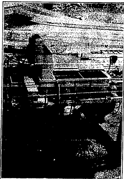
FIGURA 5.2.2.- ALIMENTACION DE TOLVA PARA LA DOSIFICACION DE LIMO, -- PLANTA DE MEZCLADO CONTINUO. PRESA SAN LAZARO, B.C.S.
