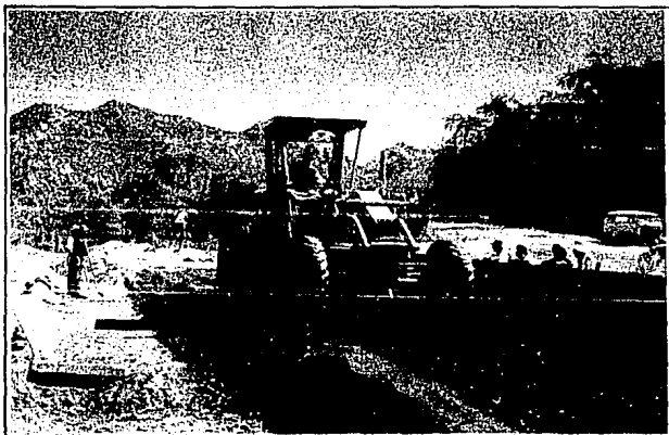
FIGURA 5.3.5.- MOTOCONFORMADORA DISPERSANDO EL CONCRETO COMPACTABLE HASTA EL SITIO EXACTO. BORDO DE PRUEBAS. PRESA SAN LAZARO, B.C.S.
