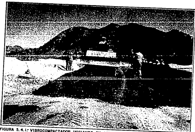
FIGURA 5.4.1.- VIBROCOMPACTADOR INICIANDO SU ACTIVIDAD EN LA CAPA DE CONCRETO - COMPACTABLE YA COLOCADA. BORDO DE PRUEBAS. PRESA SAN LAZARO, B.C.S.
