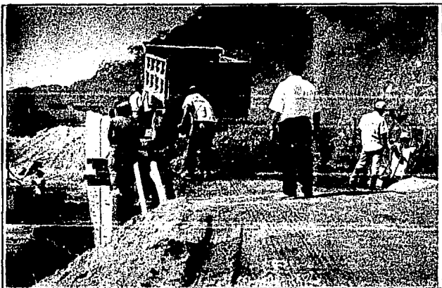
FIGURA 5.3.4. A).- SUMINISTRO DE CONCRETO COM- PACTABLE PARA LA CONFORMA- CION DE LA NUEVA CAPA. BORDO DE PRUEBAS, PRESA SAN LAZARO, B.C.S.
