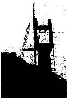
Izaje de binario (equipo de montaje).
