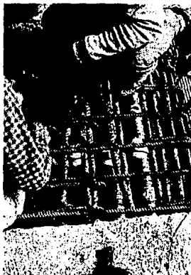
Armado en colados de liga entre dovelas.
