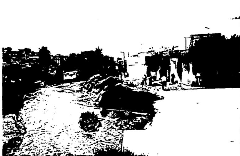
*En los tramos donde no se han recubierto los bordes con concreto o muro de mampostería, la erosión ocasionada por el importante volumen de material acarreado por el afluente provoca el debilitamiento de las orillas, como se muestra en ésta fotografía, por lo cual hay que tener cuidado al ubicar las maquinas, que pesan varias toneladas.*
