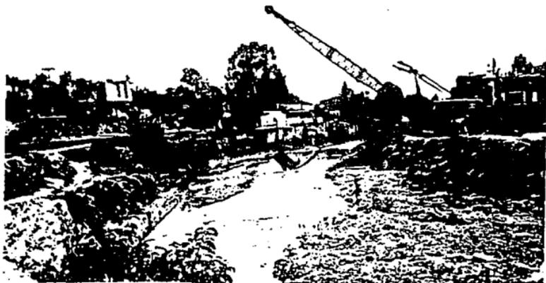
*Vista de una de las dragadoras efectuando los trabajos de limpieza en un tramo del río.*
