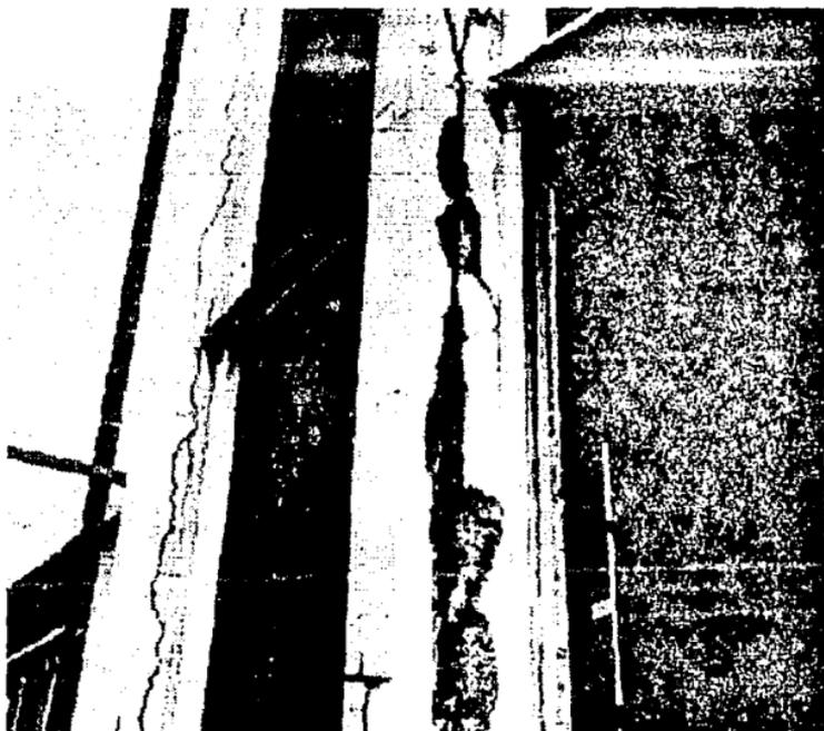
**FOTOGRAFIA II-1 OXIDACION DEL ACERO DE REFUERZO
