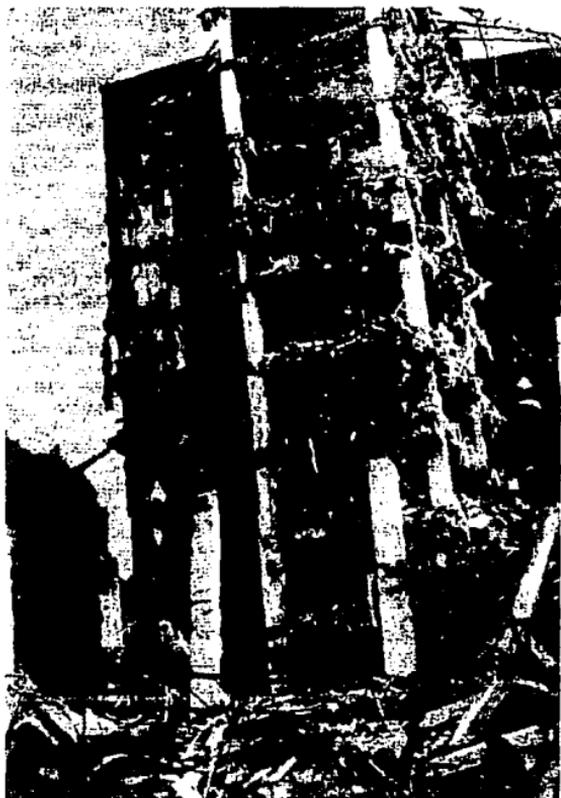
**FIGURA VI-1 FALLA POR PUNZONAMIENTO DE LOSAS RETICULARES**
