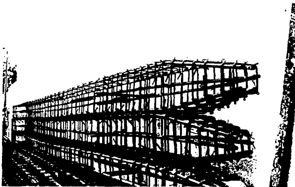
Fig. 4.6 Armado de los pilotes de concreto
