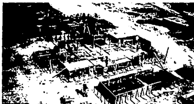
FIG. 1.2.5 SISTEMA CORTINA PREFABRICACION DE UN EDIFICIO
