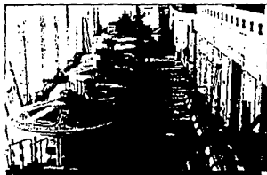
Sala de Generadores (Rehabilitación)
