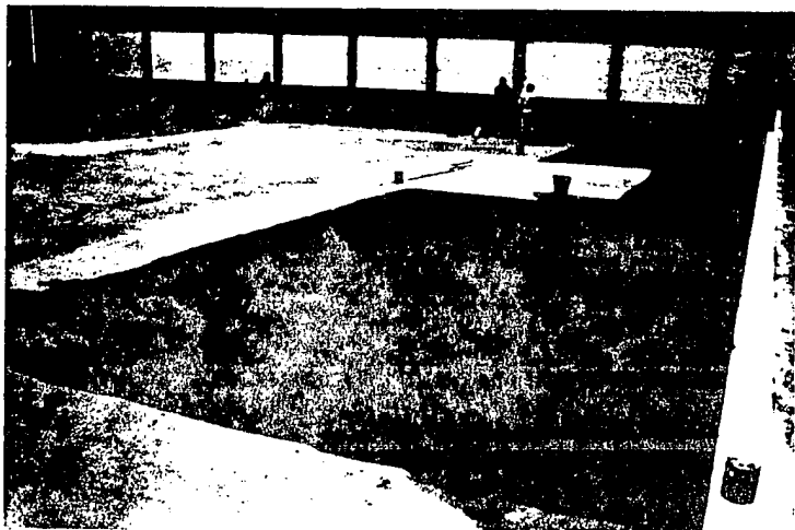
Foto 4 Vista interior del tanque. Impermeabilización de la losa de fondo.
