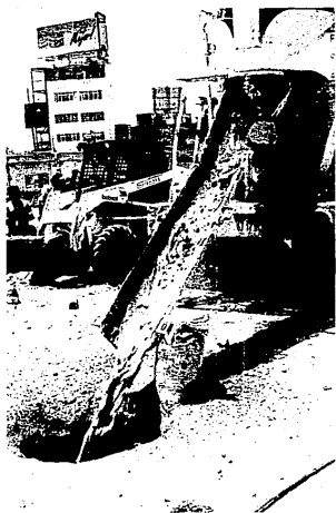
FOTOGRAFÍAS 30 Y 31: VACIADO DE MEZCLA POR GRAVEDAD POR LAS LUMBRERAS L-5 Y L-3, RESPECTIVAMENTE.
