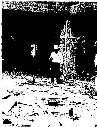
FOTOGRAFIA 7: UBICACION DE LA LUMBRERA L-2.
