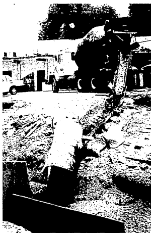
FOTOGRAFÍAS 30 Y 31: VACIADO DE MEZCLA POR GRAVEDAD POR LAS LUMBRERAS L-5 Y L-3, RESPECTIVAMENTE.
