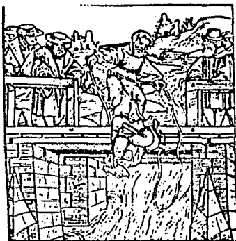
FIGURA 66. El abajamiento. Se abajaba a los condenados en rbas. ligas y escuadras, en paños y fustiles e saclos en ollas y caracolas. A veces la víctima al mismo tiempo era arrastrada en un saco hasta a una decena de pasos. Abajamiento de los condenados, principios del siglo XVII, reproducción de un grabado.
