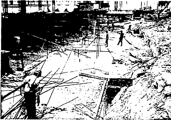
HOSPITAL DE PEDIATRIA INICIO DE CONSTRUCCION
