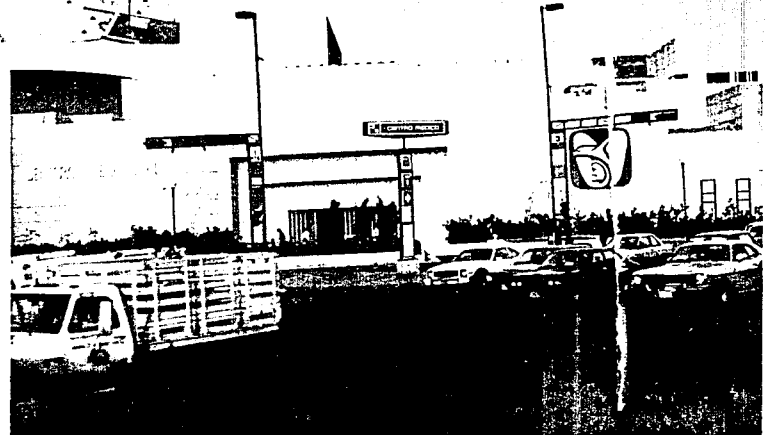
EDIFICIO DE ACCESOS
