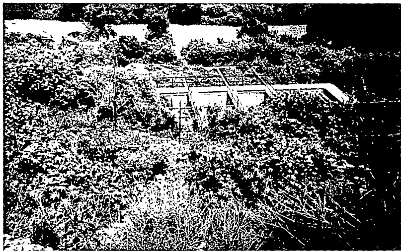
FOTOGRAFIA 6.2 ESTADO ACTUAL DE ABANDONO
