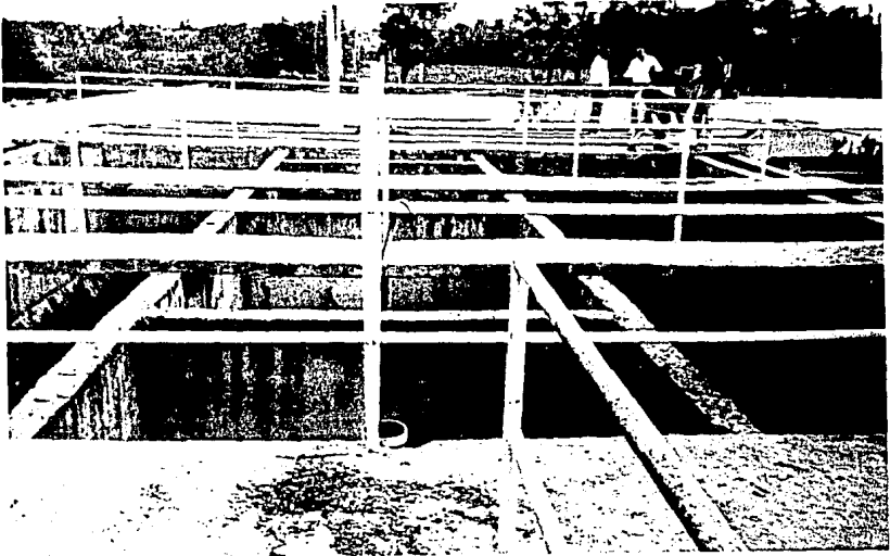
FOTOGRAFIA 6.11 DEFLEXIONES APRECIABLES
