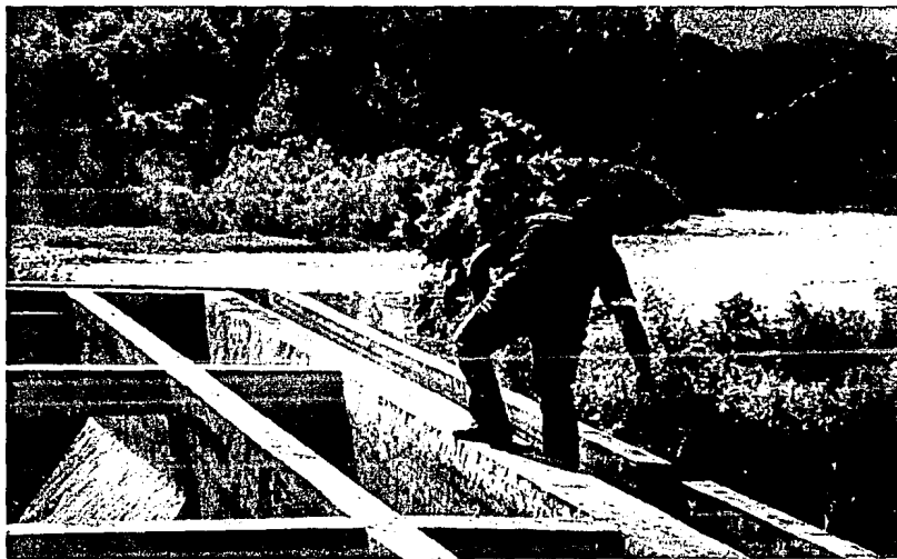
FOTOGRAFIA 6.4 VISTA SUPERIOR DE LA PLANTA Y SU CERCANIA AL RIO CAZONES
