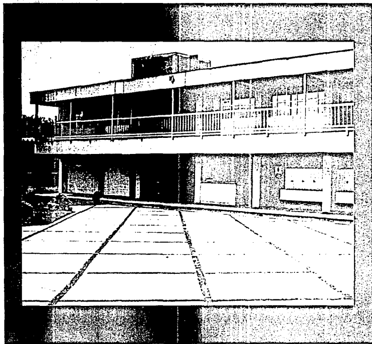
* Vista del segundo edificio. El Núcleo Sanitario se ubica en la planta baja.
