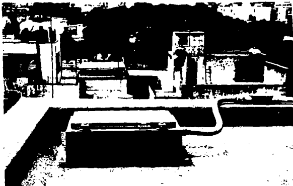
Figura 6.5 - Instalación de una EstSen en la azotea.
