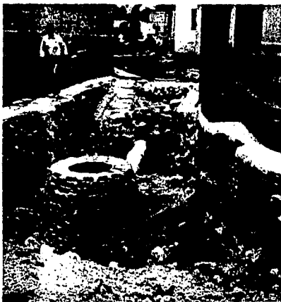
FIG. V.4. CONSTRUCCION DE POZO DE VISITA COMUN.
