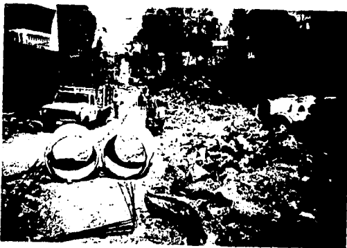
TRABAJOS DE EXCAVACION
