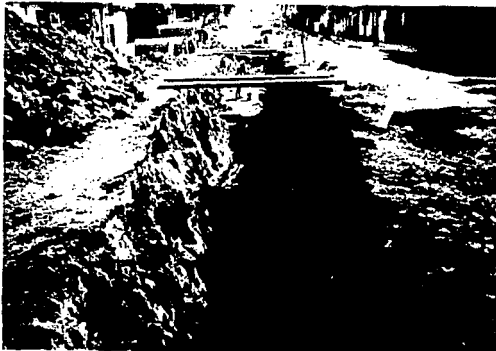
FIG. V.3. RELLENO DE CEPAS CON TEPETATE EN CAPAS DE 20 CM.
