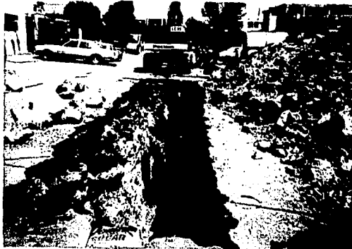
TRABAJOS DE EXCAVACION EN ROCA
