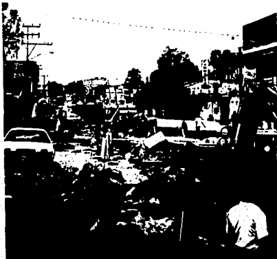
CONSTRUCCION DEL TRAMO IX-A
