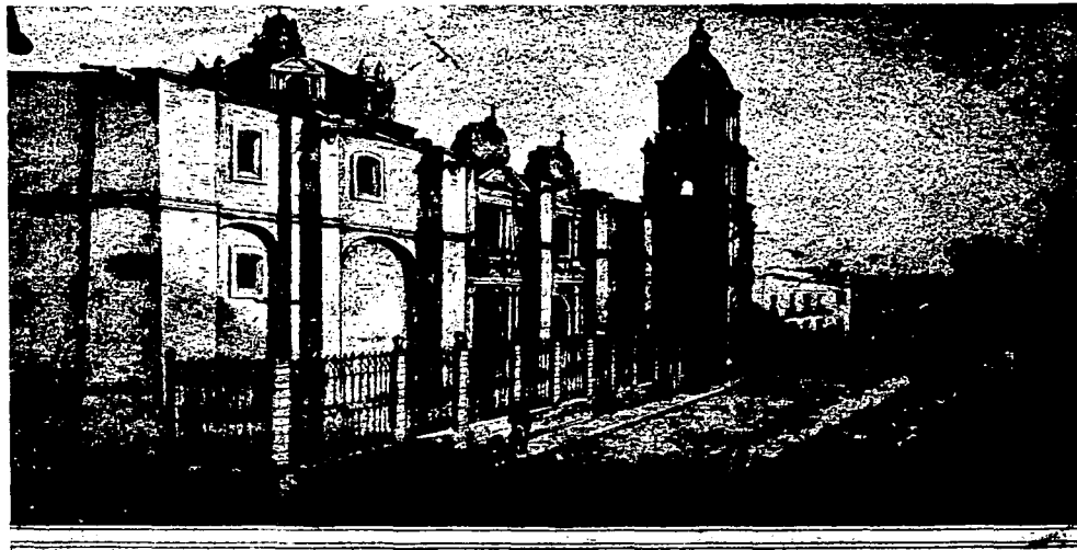
Litografía del majestuoso templo de la Concepción, antes de la exclaustación mostrando el enverjado que hoy ha desaparecido. (Fotografía del Archivo de la Dirección de Monumentos Coloniales).
