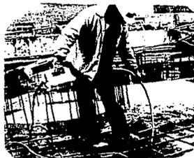
EL CABEZAL ES LA PARTE QUE ENTRA EN CONTACTO DIRECTO CON LA MEZCLA, LAS VIBRACIONES SE PRODUCEN DEBIDO A QUE UN EJE ROTOR GIRA DENTRO DE UN TUBO VIBRADOR.
